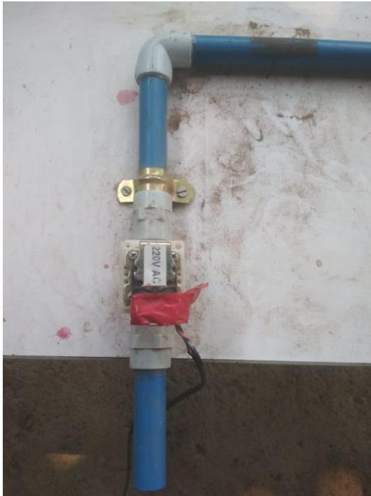
Fig. a. Solenoid Valve
